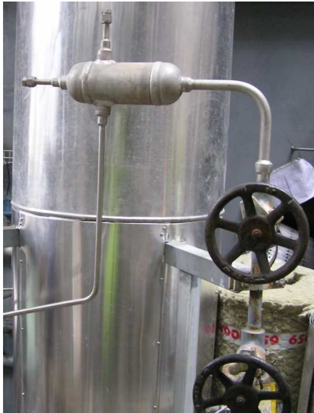
BALÓN DE CONDENSADOS
