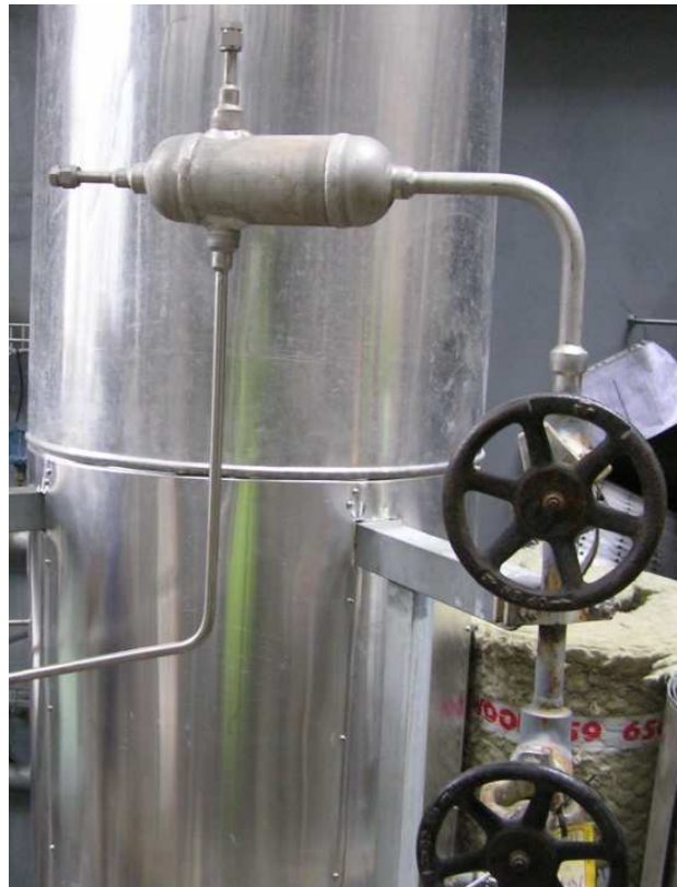
BALÓN DE CONDENSADOS
