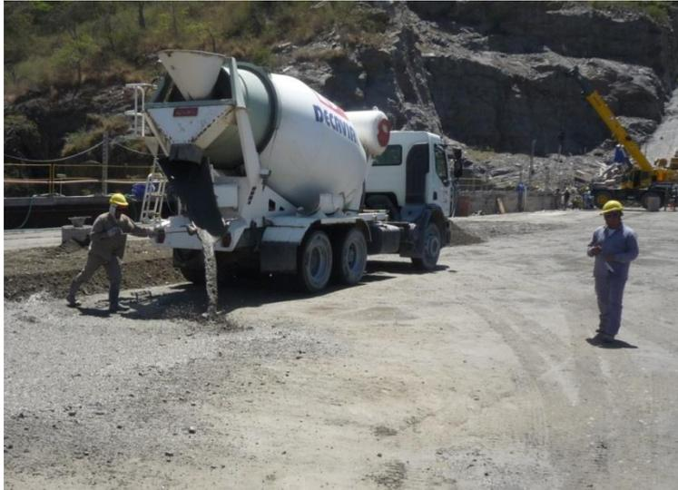
*Fotografía N°15. Colocación mortero de liga entre capas de HCR.*
