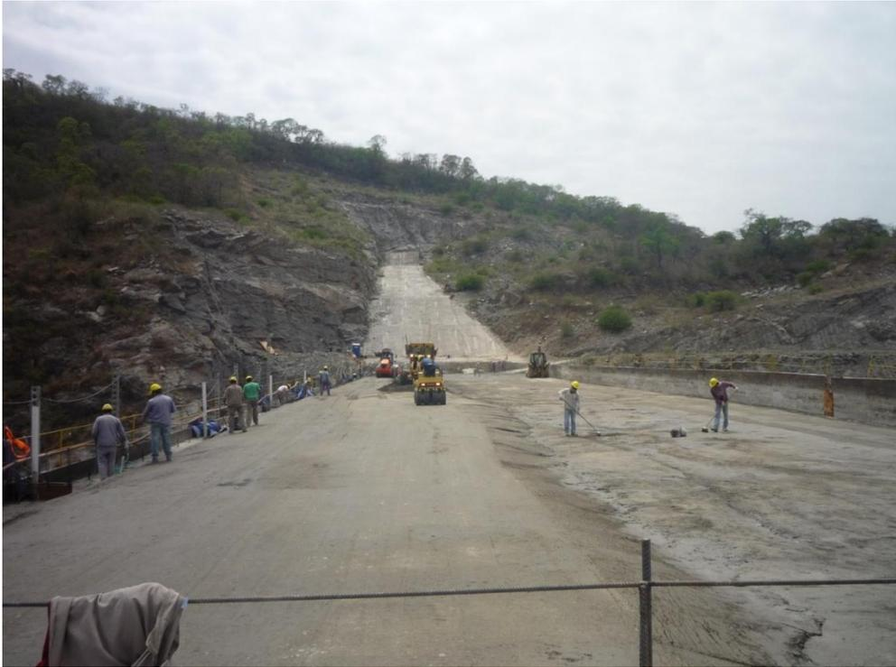
*Fotografía N°18. Ejecución de HCR en la presa principal.*
