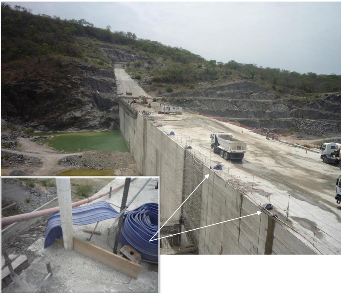
*Fotografía N°19. Ejecución de juntas en la presa principal.*
