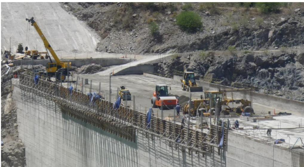
*Fotografía N°17. Ejecución de HCR en la presa principal.*
