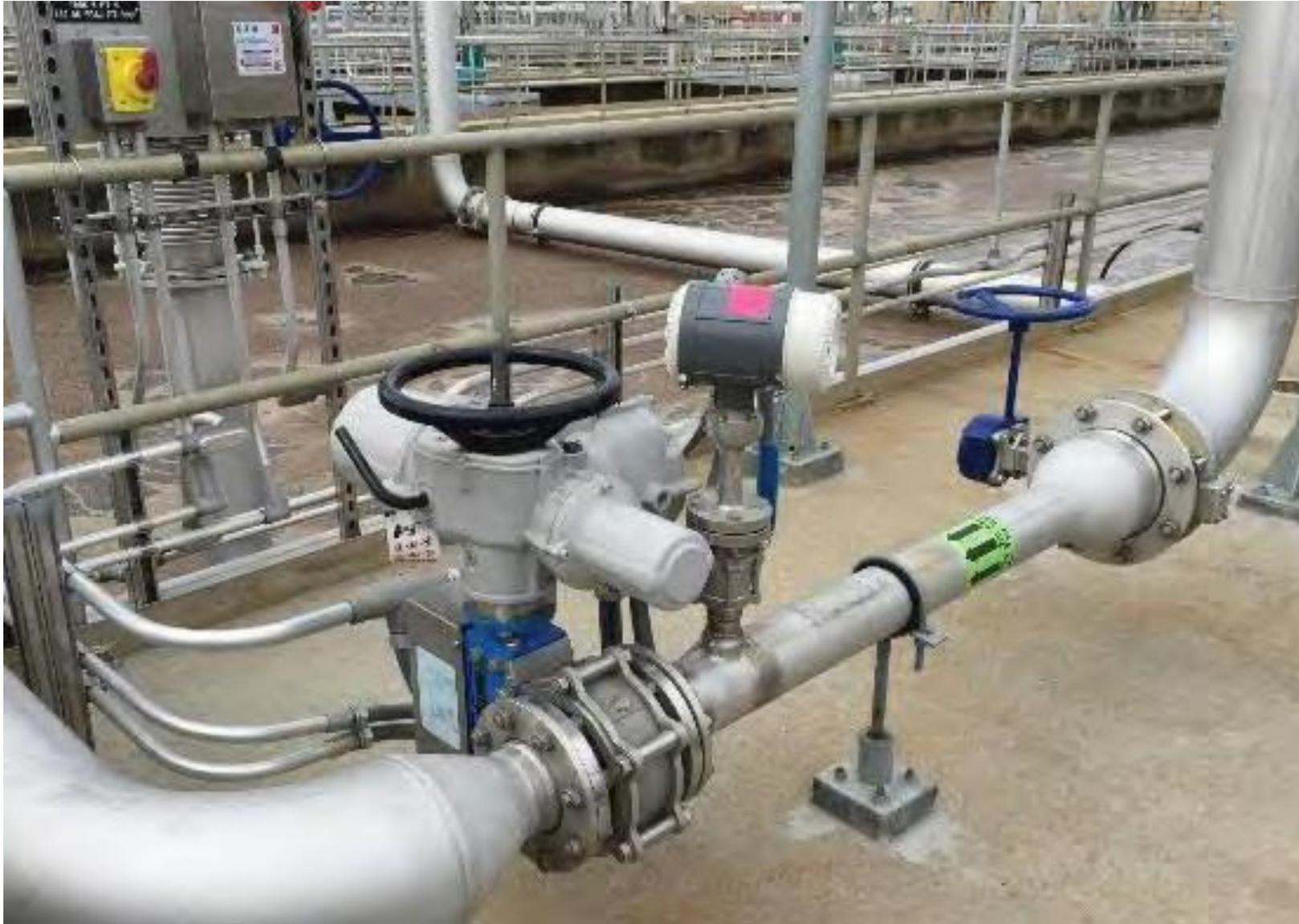
Se puede observar la reducción (y expansión) de diámetro con ángulo pronunciado, enderezador de vena fluida (antes de la válvula) y caudalímetro insertado antes de la admisión del elemento final de control
