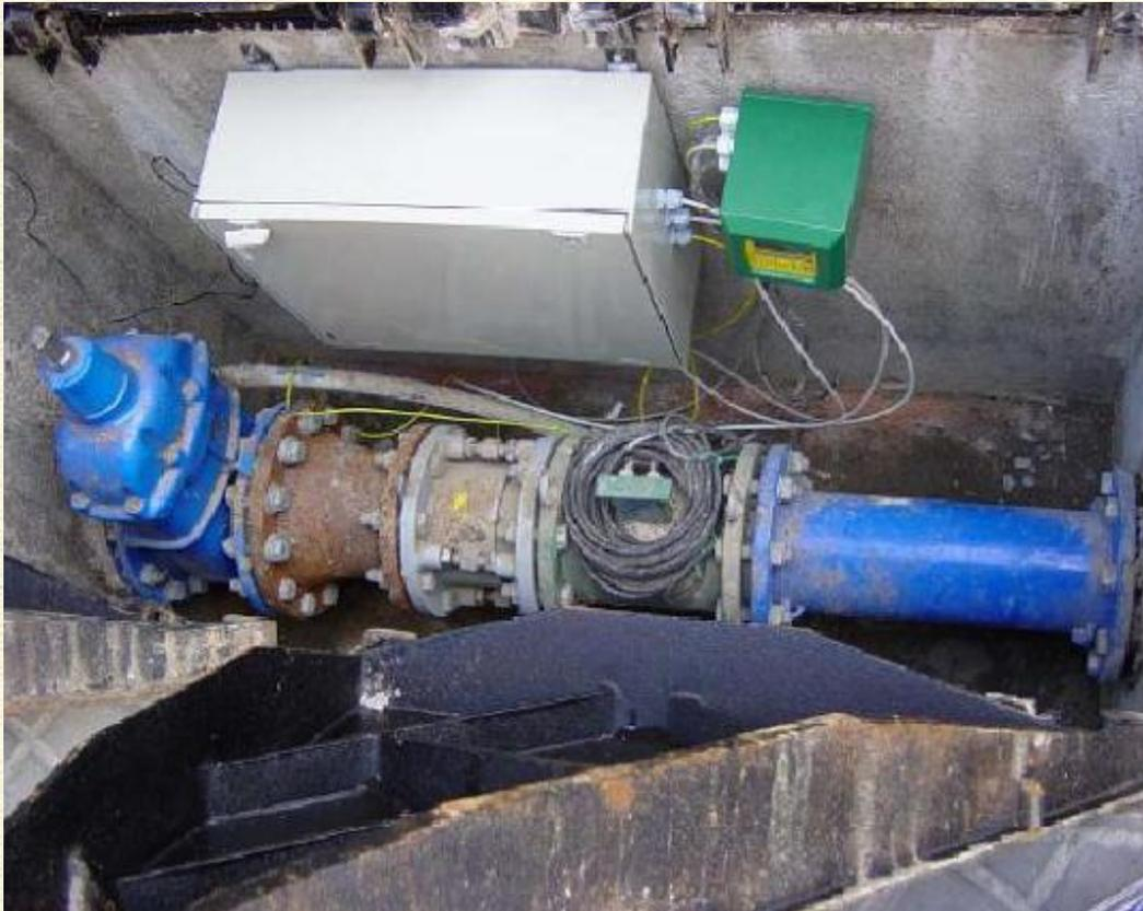
Pueden medir caudales del fluido en ambos sentidos en la cañería. Además este medidor es **no invasivo** pues no tiene elementos que obstruyan el paso del fluido.
