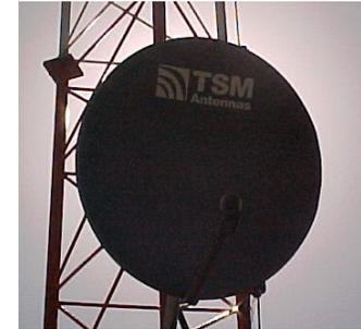
**Definición:** Consiste en una antena (con alimentador) que ilumina un reflector parabólico que reirradia esa energía en una dirección de máxima ganancia.
