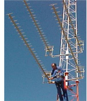
**Concepto:** Antena direccional compuesta de un reflector (una simple barra) un dipolo simple o doblado y varios directores.
