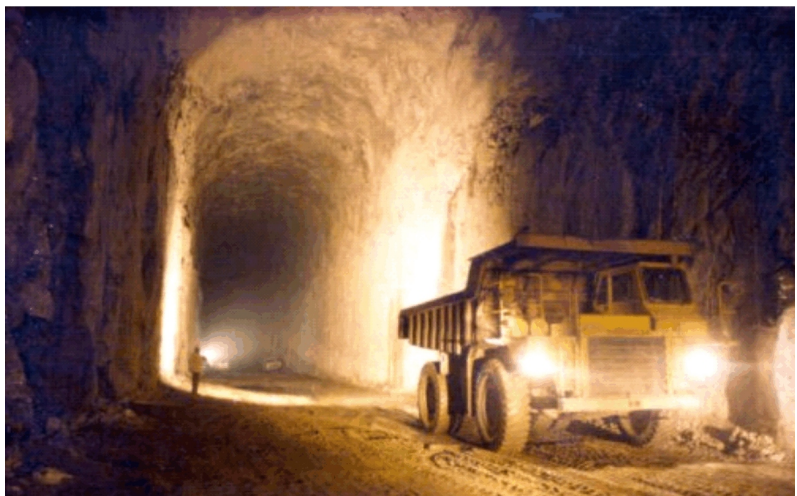
Figura 1. Excavación del Túnel de Restitución
