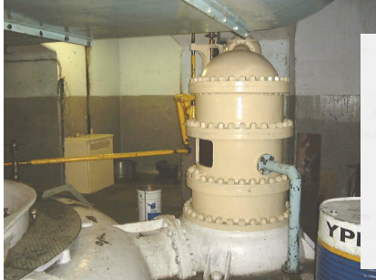
Fig. N°25-Orificio compensador obturado por válvula o válvula sincrónica, T.H. Escaba
