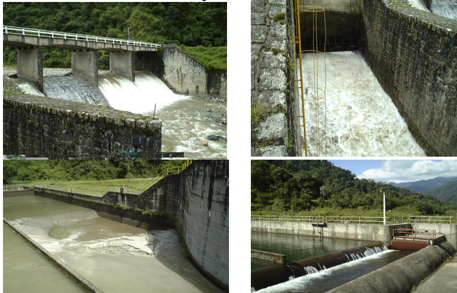
A - Asud o cierre para derivar el agua del río. B - Compuerta de toma construida en el Asud. C - Vista de tolba del desarenador. D - Canal de toma que conduce el agua a la central
