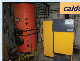
Central Térmoelectrónica usando Biomasa
