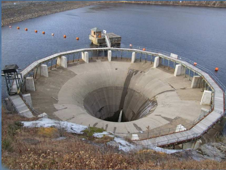
Aliviadero de la Presa de Monticello en el Lago Berryessa, en California
