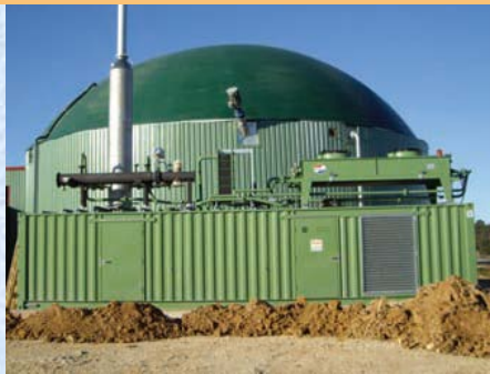
Digestor anaerobio de la Granja San Ramón en Requena (Valencia).
