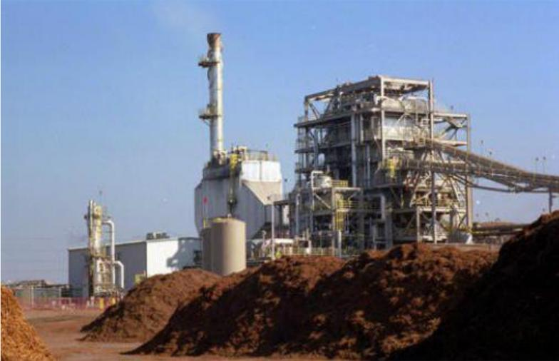
Una planta de valorización de BM debe disponer de un sistema de pretratamiento de BM, cuyo fin es la disminución de la humedad que contiene y la adecuación del tamaño de la BM, con el fin de uniformizar las condiciones de entrada en la caldera y conseguir la mayor eficiencia del sistema de combustión.
