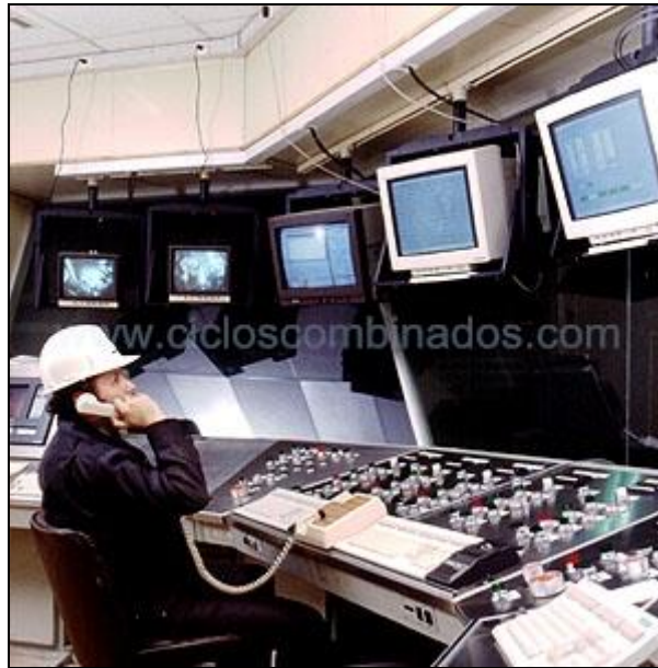
Sala de control de una Central de CC
